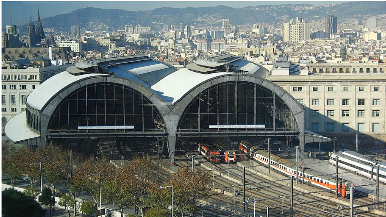
Figure 21. Barcelona Estación de França
