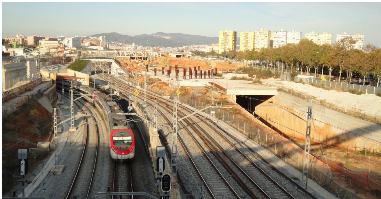
Estación de Barcelona-La Sagrera construction site
