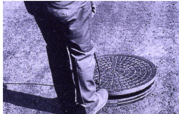
b. Install Manhole Riser Ring
